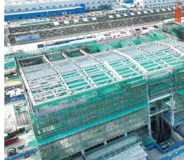
海南昌江核电厂多用途模块式小型堆科技示范工程“玲龙一号”外穹顶在进行吊装作业(无人机照片)。
