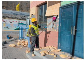
1月11日,记者走进积石山县石塬镇肖红坪小学和柳沟乡阳山希望小学等学校维修施工现场,看到甘肃建投临夏公司、项目办、监理单位等采取不间断施工方式,抢抓项目建设进度,工人们铆足干劲对每个维修部位进行逐个排查,并搭起架子拆除危墙、清理楼内墙面裂缝处水泥块,做好教室内墙面粉刷及外墙保温工作,现场一派繁忙景象。
