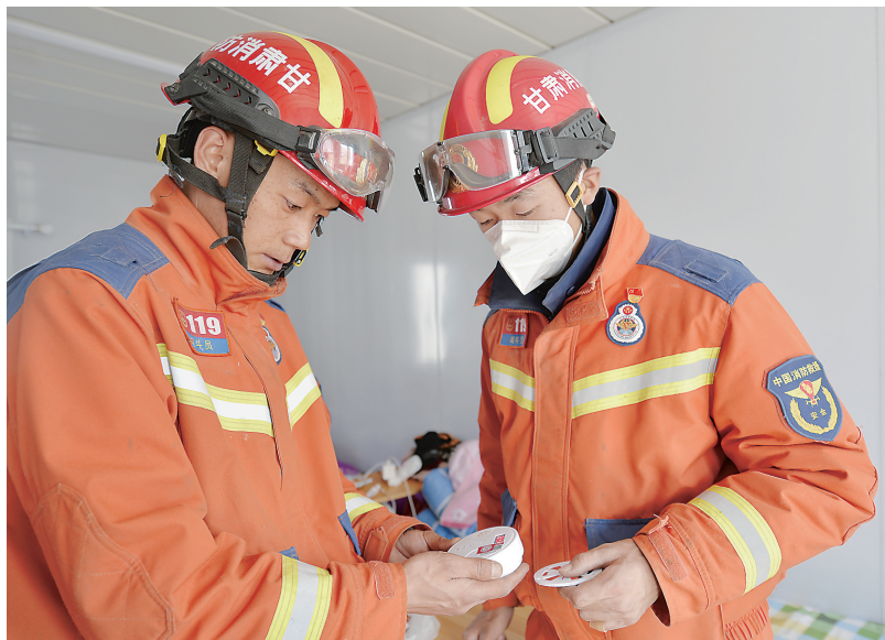
消防人员在活动板房安装防煤气中毒报警装置
