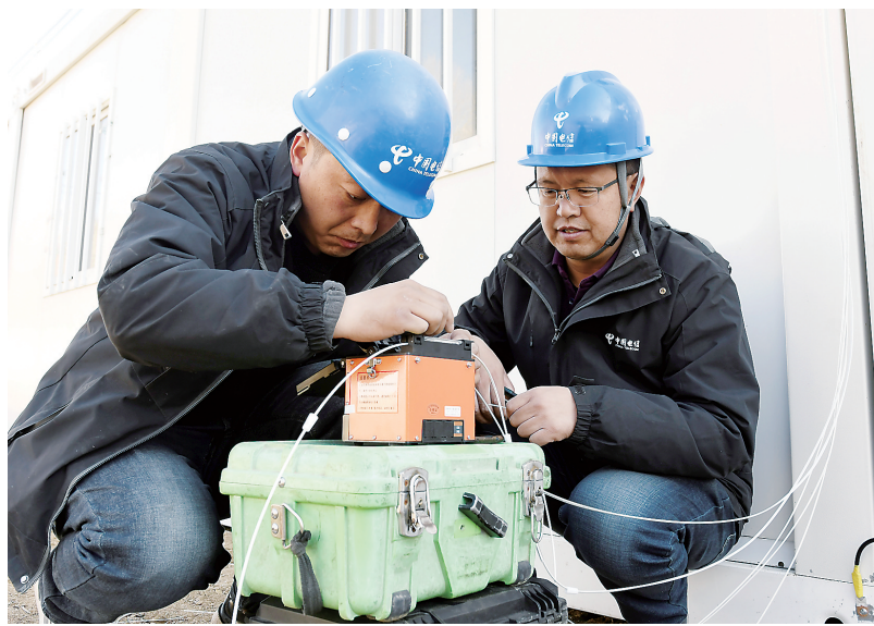
电信工作人员在活动板房安装免费宽带
