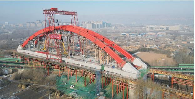
本报讯 (记者 史有东 通讯员 石祥)12月28日,由中铁大桥局承建的兰合铁路4标杂张家立交特大桥跨乌玛高速144米系杆拱桥顺利合龙。
