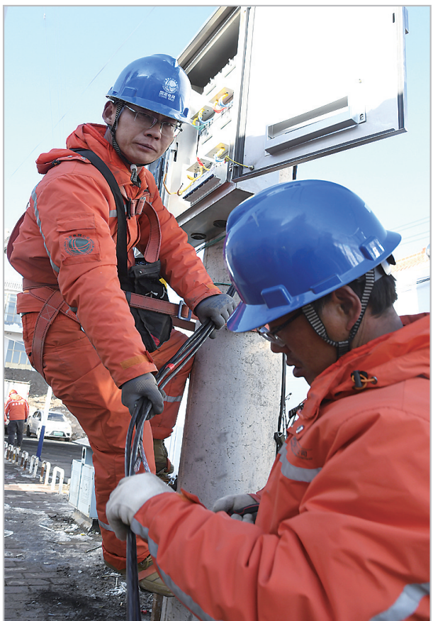
在安置点接通电线
