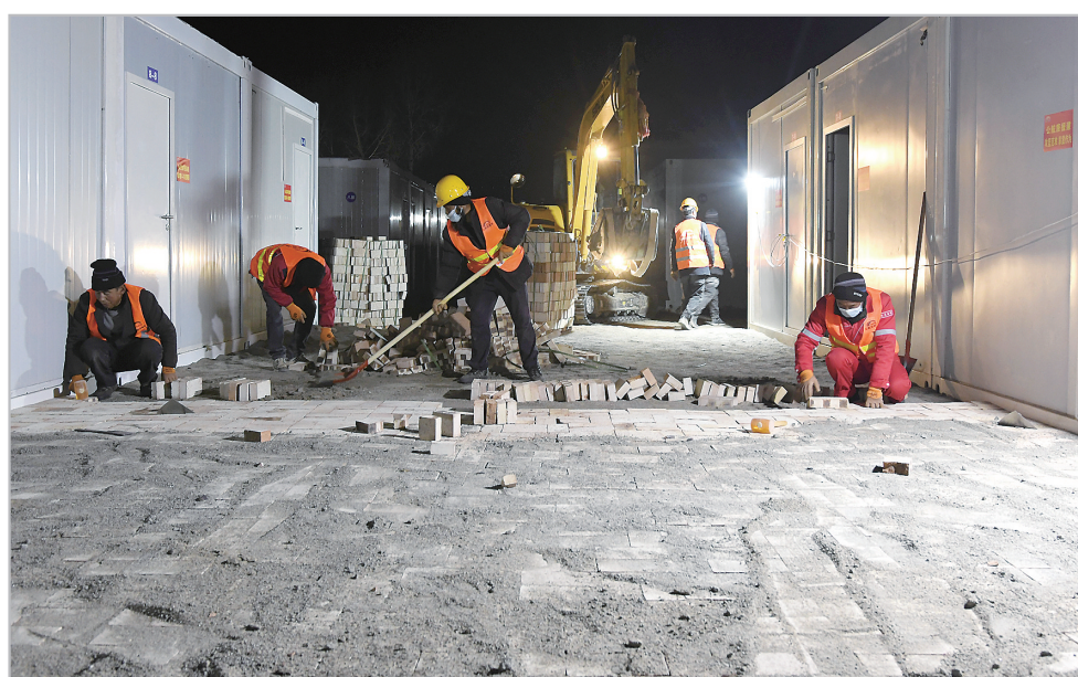
施工人员在安置点加班加点铺设道路
