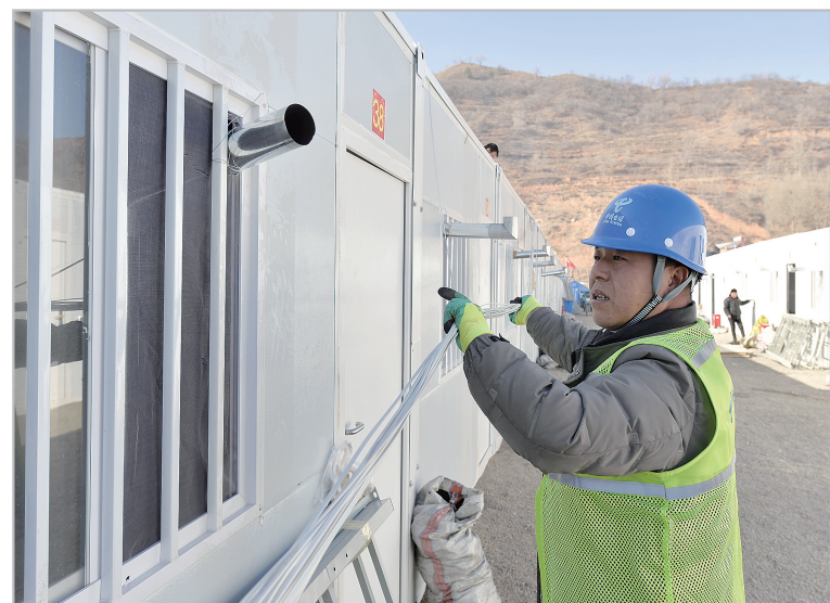
在安置点活动板房安装宽带网线
