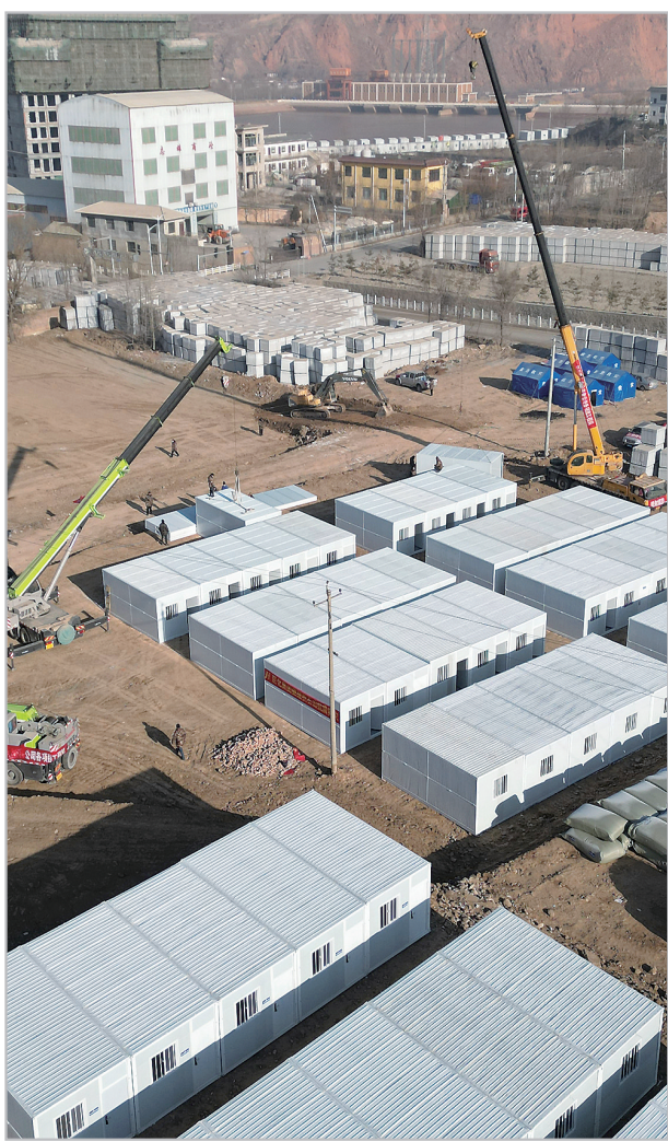
大河家镇康吊村安置点施工人员在吊装活动板房
