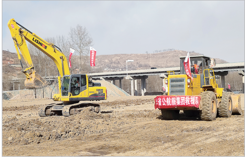
施工人员为吹麻滩镇安置点建设箱式板房平整土地
