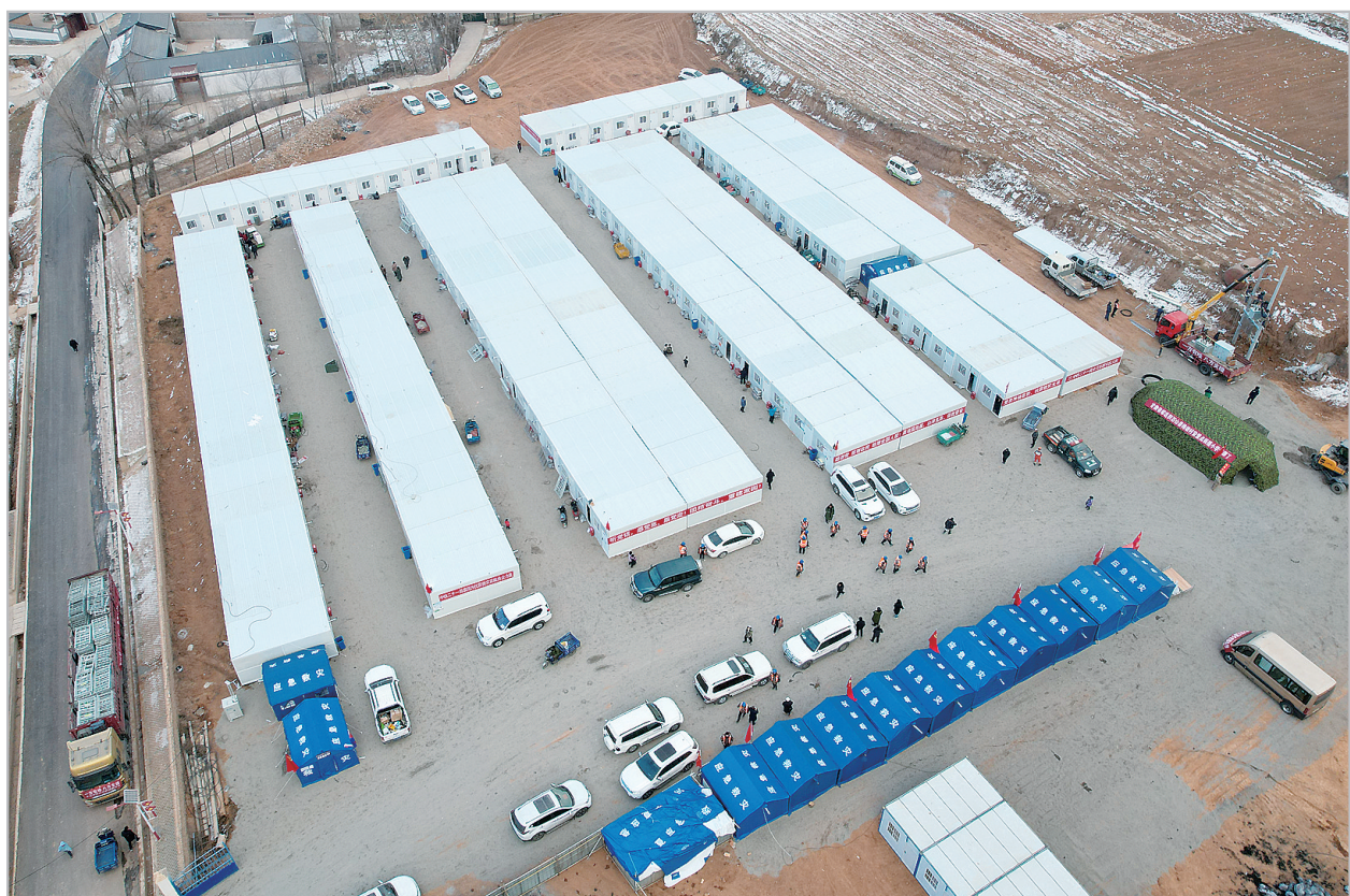
大河家镇梅坡村安置点
