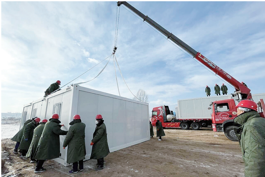
施工人员在吹麻滩镇前庄村安置点搭建板房
