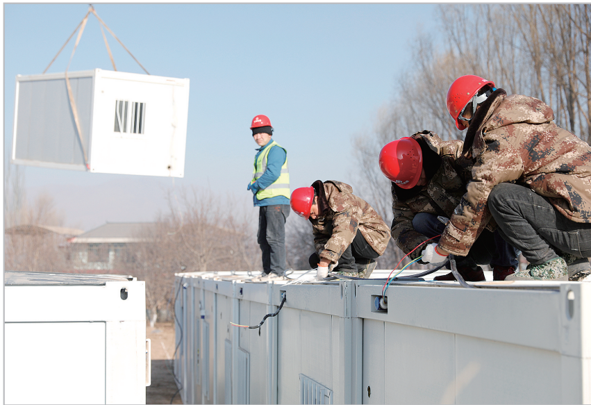
施工人员为刘集乡陶家村一集中安置点的活动板房接通电源。
