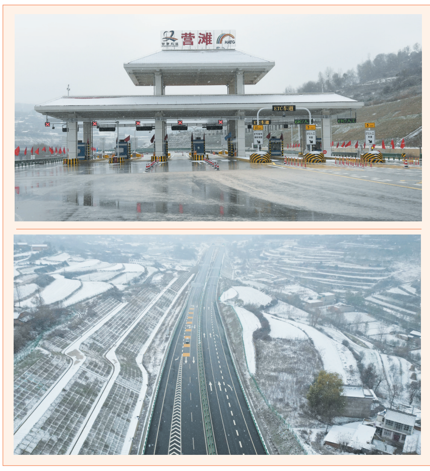
架起,长3.2公里的大墩峡隧道,主桥跨径120米、最大墩高95米、全长938米的关沟沟大桥,全长2017.5米的禹王特大桥
