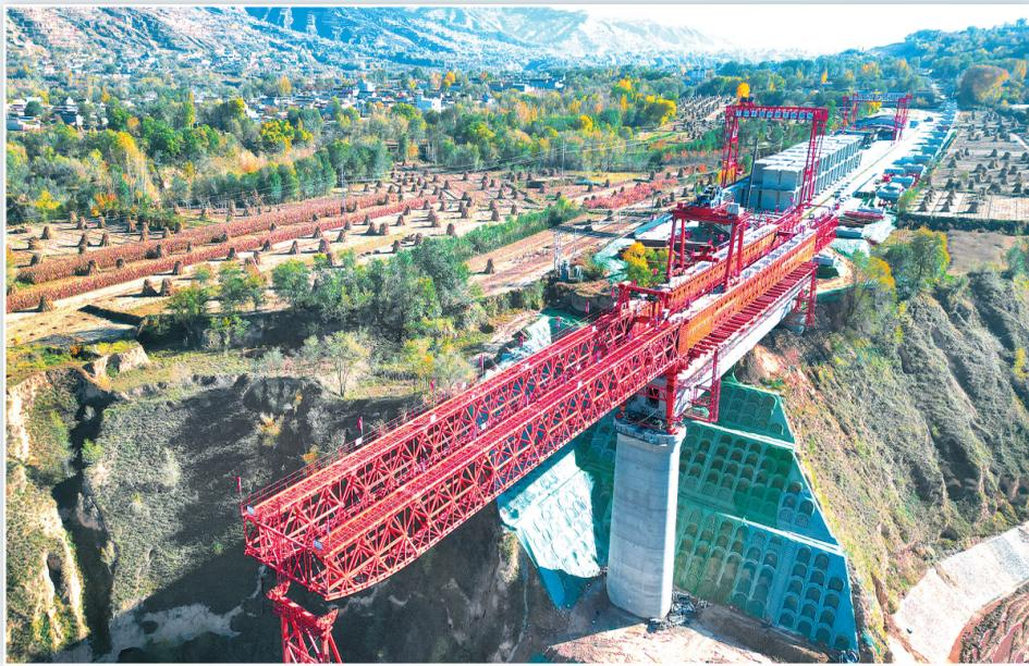
兰合铁路泄湖峡大夏河特大桥首孔64米节段胶拼梁架设成功
