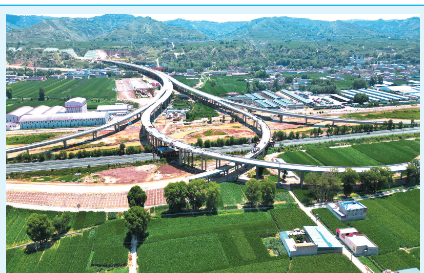
临康广高速公路项目建设现场
