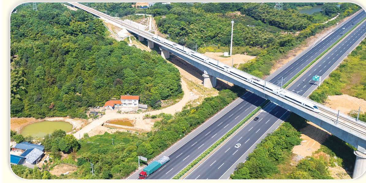
9月6日,高铁列车行驶在渝昆高铁益长段跨益长高速特大桥上(无人机照片)。当日,渝(重庆)厦(厦门)高铁益阳至长沙段正式开通运营,标志着湖南省益阳市迈入高铁时代,湖南14个市州实现了高铁全覆盖。新华社记者 陈思汗 摄
