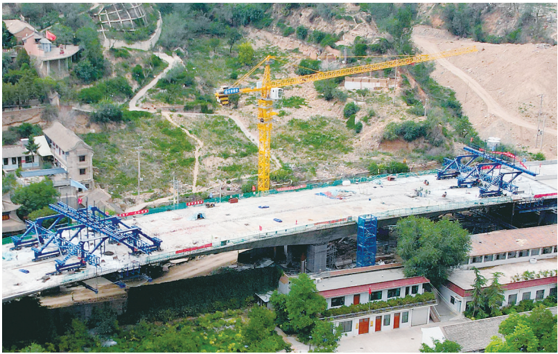
连日来，在做好疫情防控工作的基础上，临夏市环城北路项目建设稳步推进。日前，该项目古河州酒厂段高架桥挂篮连续梁顺利合拢，该段高架桥全长1.18公里，挂篮连续梁总长度220米，桥面宽度23.5米。
