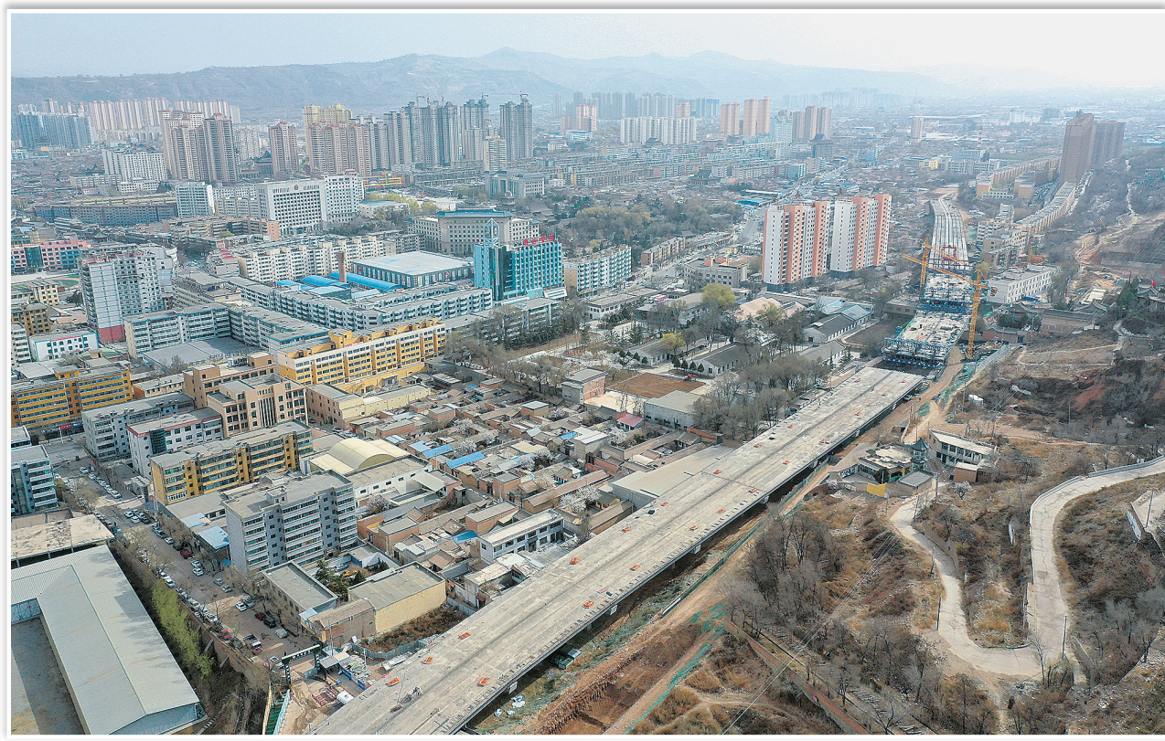
3月30日,临夏市环城北路建设项目古河州酒厂段高架桥挂篮连续梁9号块完成浇筑,为加快下一步施工奠定了基础。 本报记者 梁永吉 乔栋明 摄
