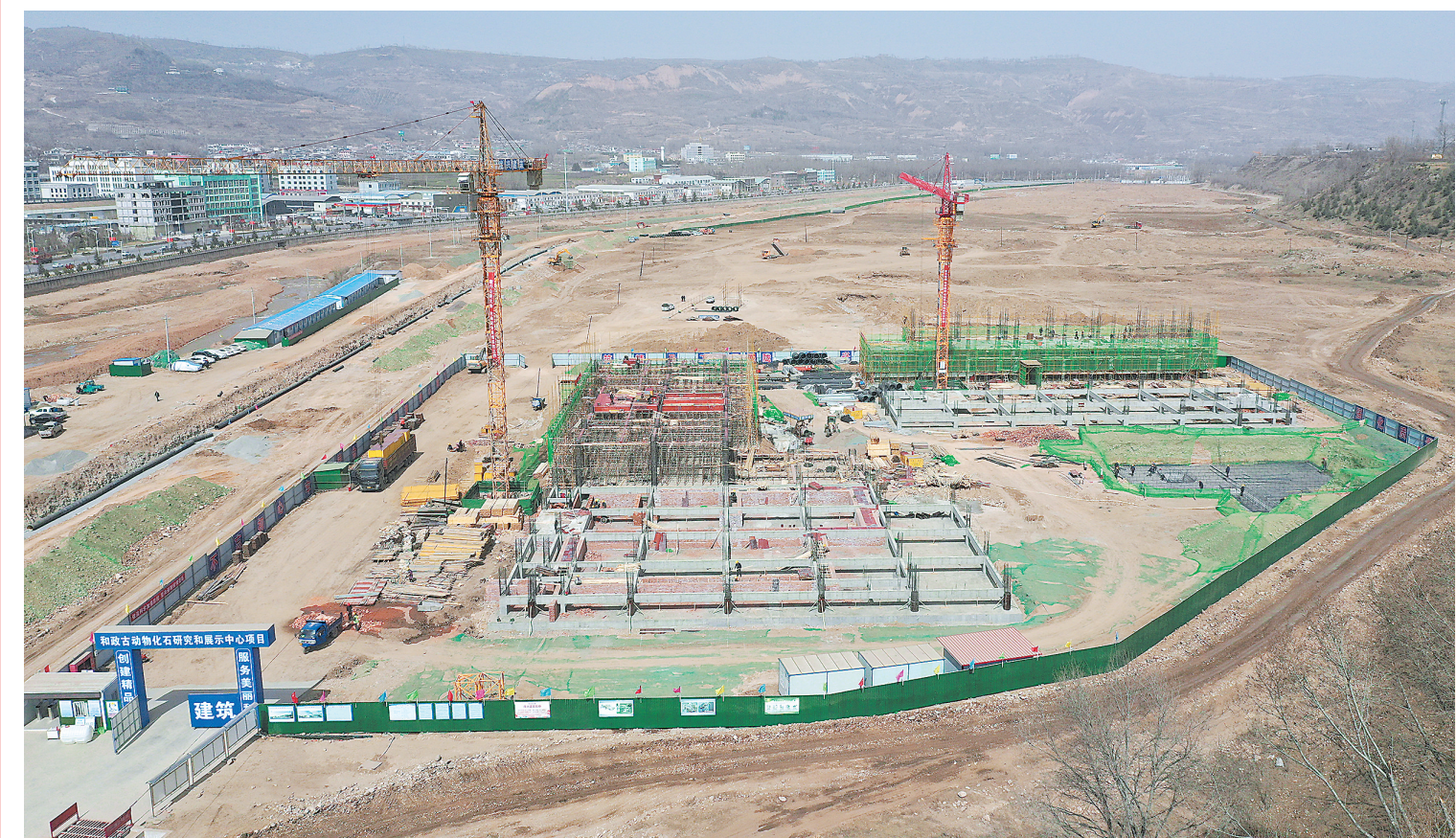
和政古动物化石研究和展示中心项目占地25.06亩,将新建古动物化石研究和展示中心、化石存储及展示空间等。目前,项目主体工程正在加紧建设中,项目进展顺利。本报记者 梁永吉 摄
