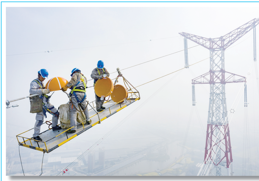
3月14日，在安徽芜湖的长江边，安徽送变电工程有限公司施工人员在高空进行特高压输电线路跨江作业(无人机照片)。
