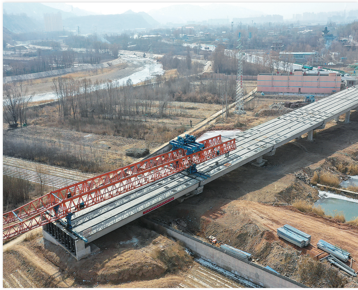
3月1日,工人在环城北路折迭路跨线桥施工。近日,随着天气逐渐回暖,临夏市环城北路建设项目陆续复工,施工现场一派繁忙。 本报记者 史有东 摄
