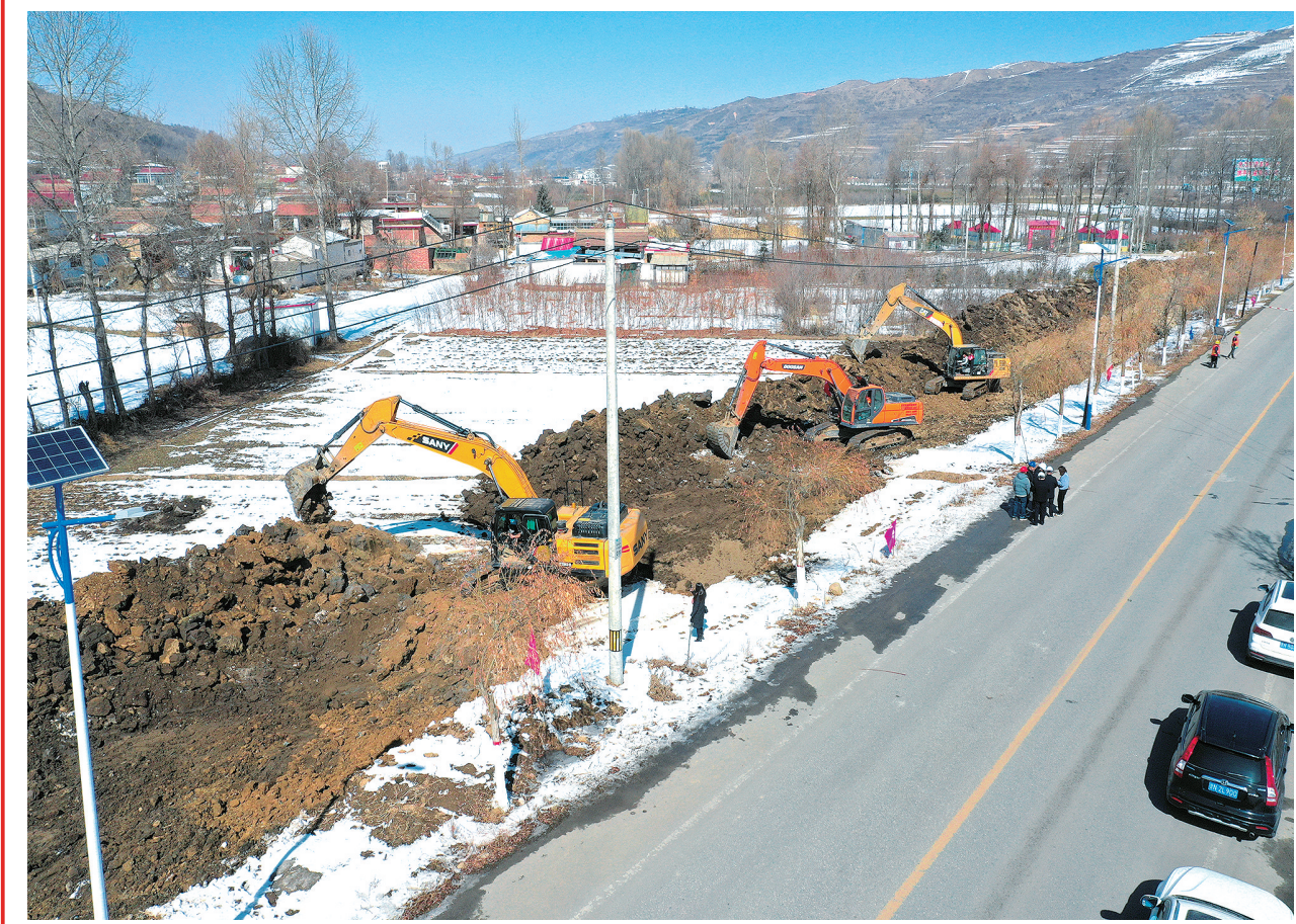
▲和政县城乡水源保障工程总投资约4800万元,建成后解决县城和城关、三合等8个乡镇、6.1万人饮用水问题。目前,该工程已完成管道开挖14.5千米、管道焊接9千米,预计将于7月份投入使用。 本报记者 梁永吉 摄
