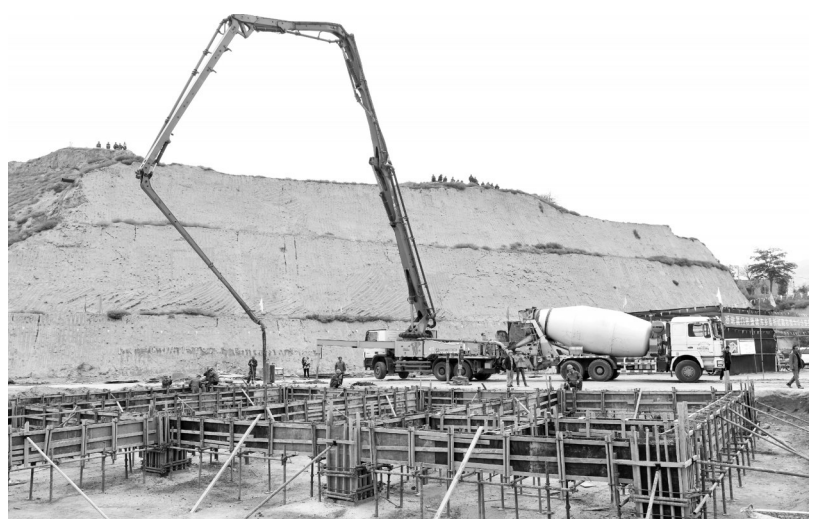
近日,由厦门市援建的东乡县高山乡布楞沟村折红路综合服务区项目开工建设,该工程总投资500万元,占地1.47万平方米。图为施工现场。 本报记者 史有东 摄
