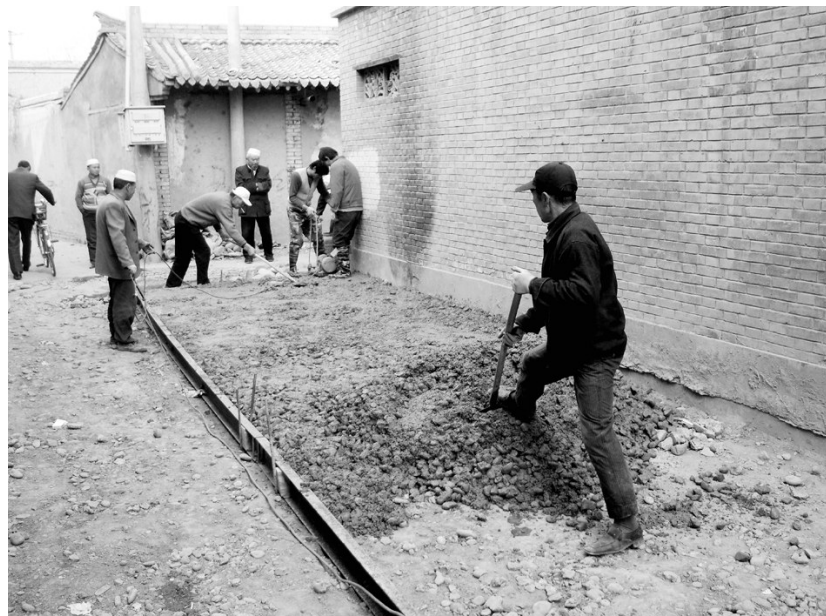
为加快临夏市八坊街道基础设施建设步伐，改善居民生活、居住环境，八坊街道党工委、办事处以群众集资、政府补助形式共同集资对路面进行硬化。硬化路面长340米，平均宽6米，总面积2040平方米，投入资金16.2万元。该工程从3月上旬动工，4月中旬将完工。 丁旭华 摄
